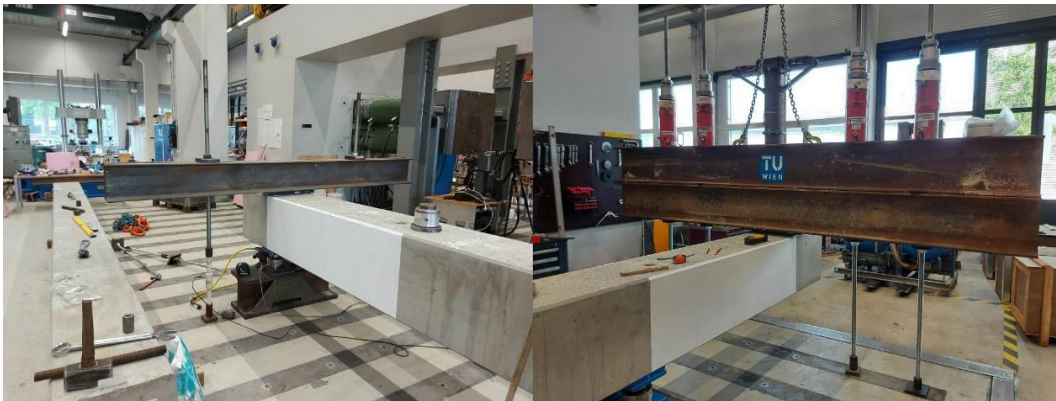
Abb. 23: Versuchsaufbau der Querkraftversuche (Kragarmversuche ohne Bauteilfuge)
