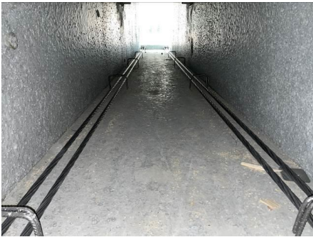
Abb. 10: Externe Vorspannung
