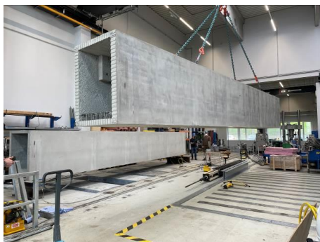
Abb. 8: Einheben der Hohlkästen: Die Fugenausbildung gemäß AP5 ist gut ersichtlich
